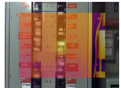
Combinación al 50%, modo Picture-in-Picture (PIP: Imagen en imagen)
